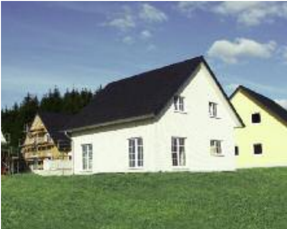
Einfamilienhäuser, bei Gummersbach
